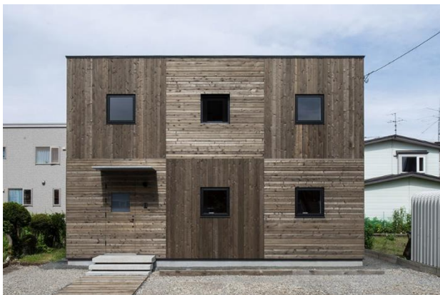
図2 実測対象住宅Aの外観
