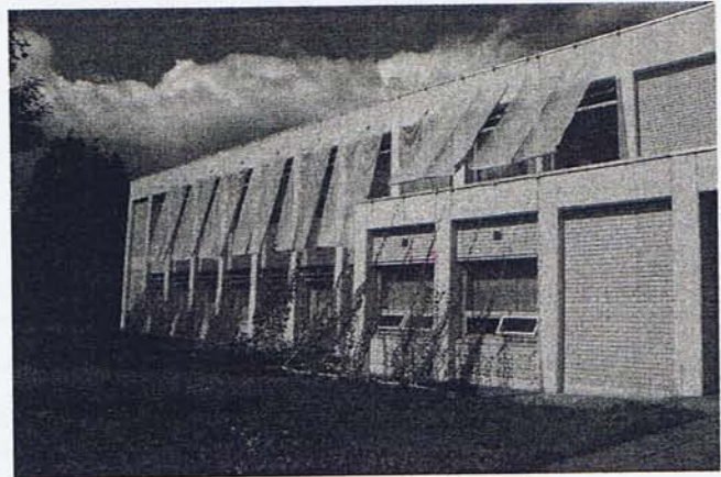
図-1 図書館東面の壁面緑化・日射遮蔽の風景 (2010年8月6日撮影)
